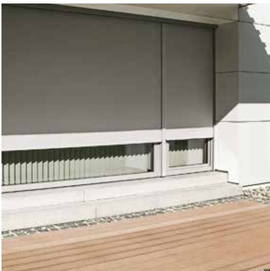
Kombination aus außenliegendem Hitzeschutz und innenliegendem Blendschutz
